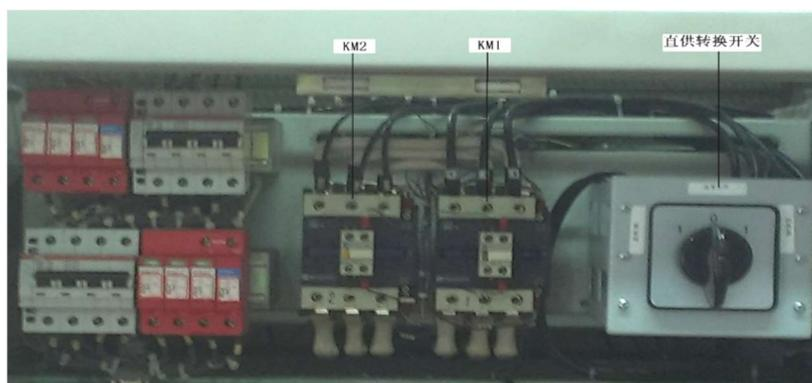
(图二中 KM1 对应 I 路外电网接触器, KM2 对应 II 路外电网接触器)
